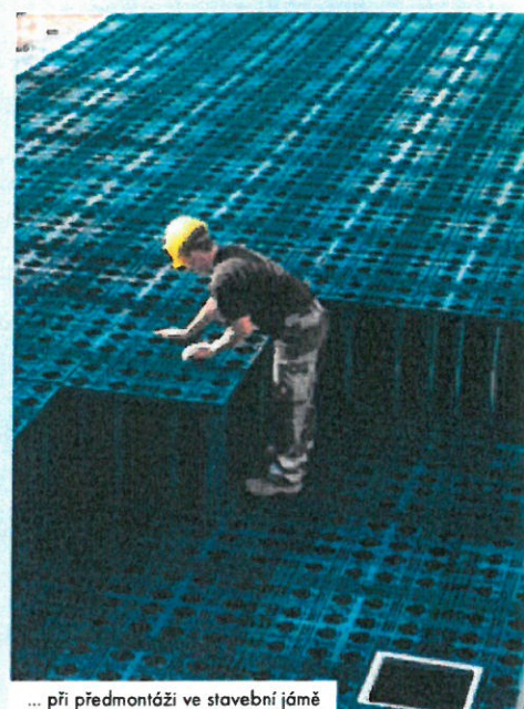
... při předmontáži ve stavební jámě
