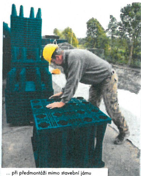
... při předmontáži mimo stavební jámu
