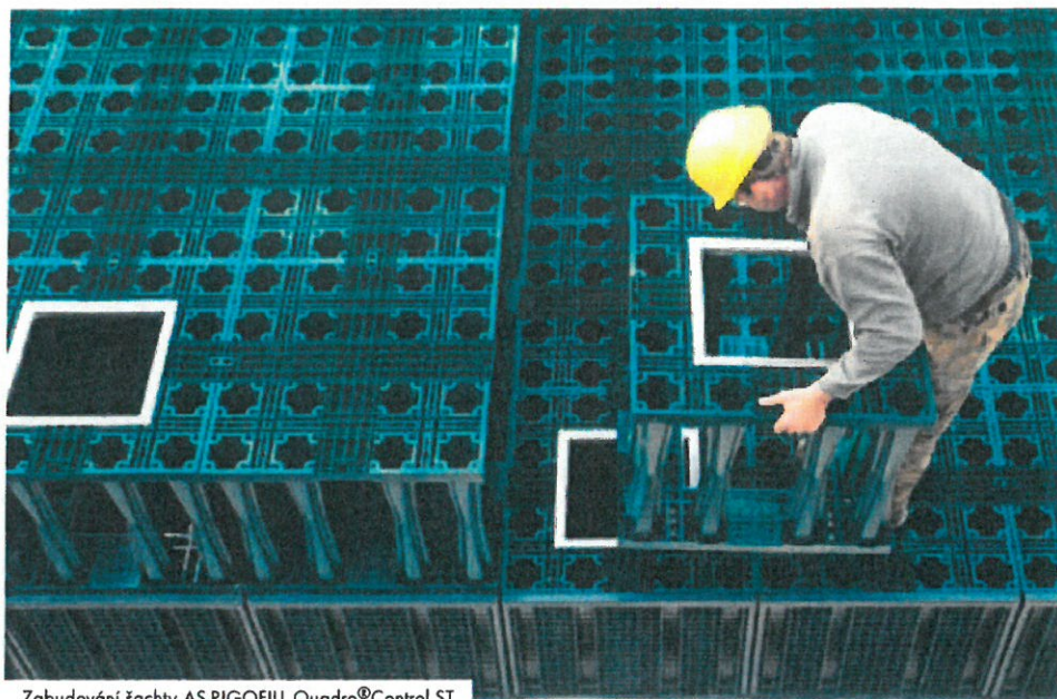
Zabudování šachty AS-RIGOFILL Quadro®Control ST
