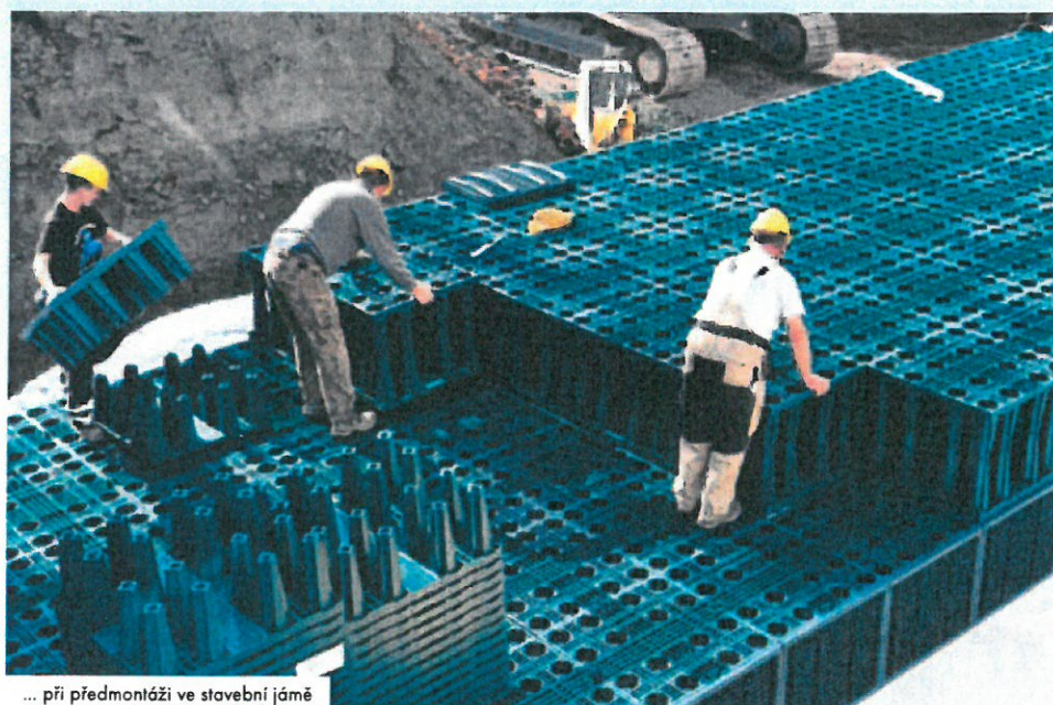
... při předmontáži ve stavební jámě
